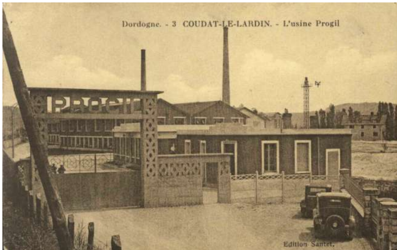
Entrée de l'usine
