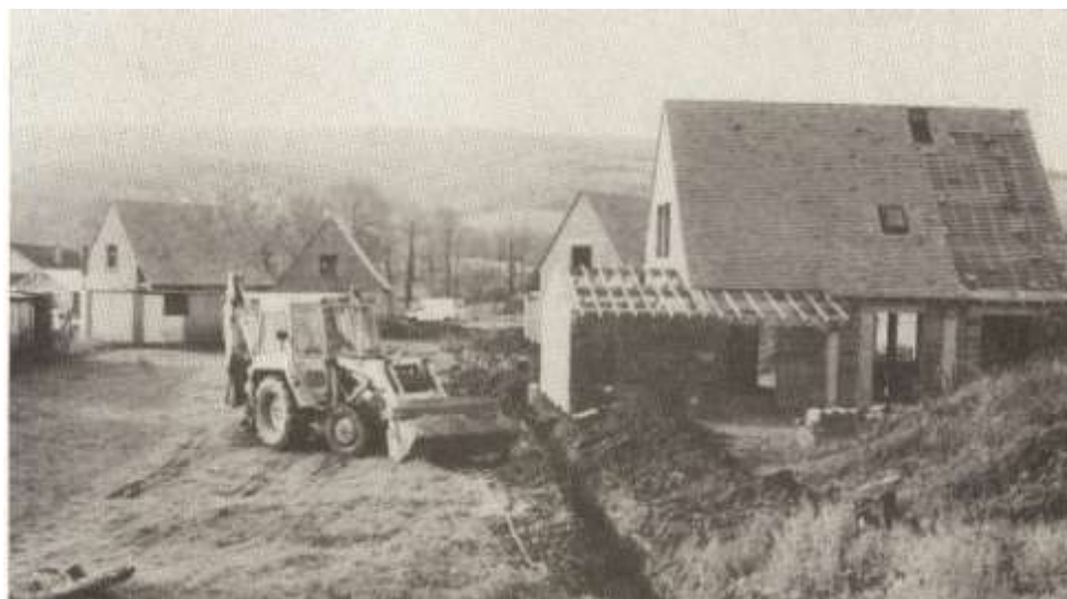
Construction des pavillons aux Maléties
