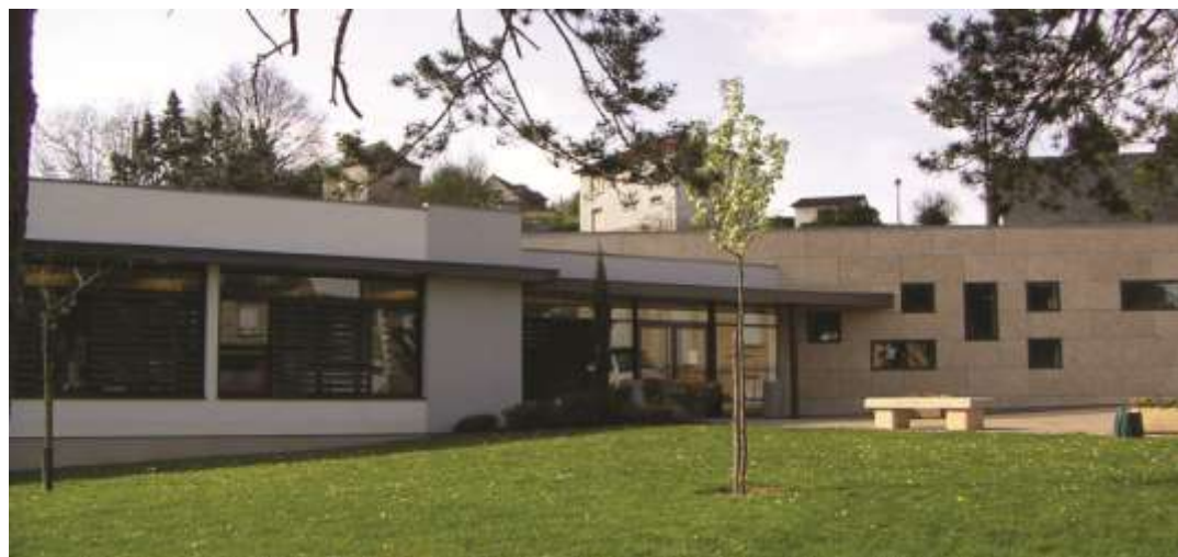
Les nouveaux locaux administratifs de la mairie
