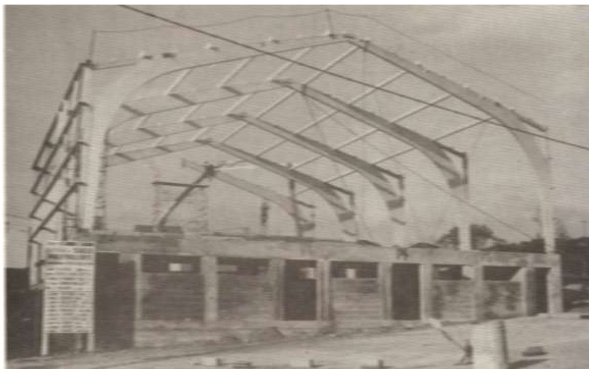
La salle polyvalente en plein construction
